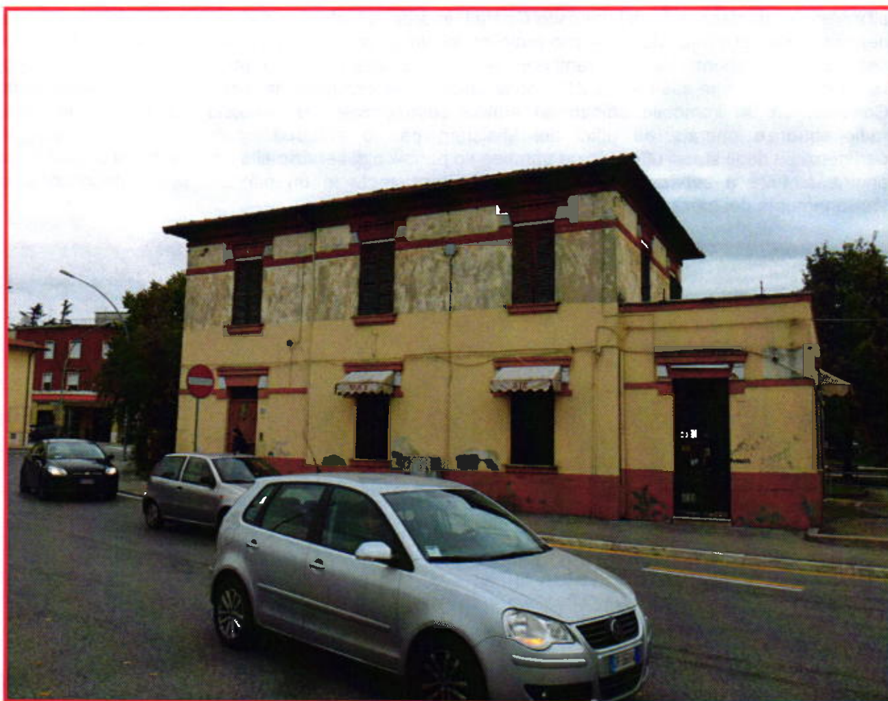
EDIFICIO "A" - vista frontale
