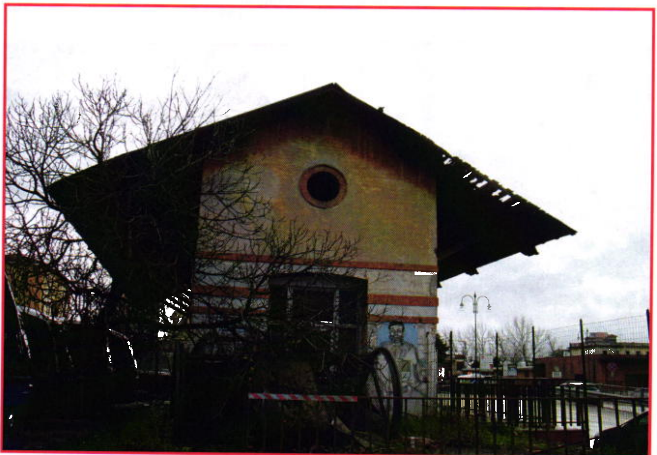
EDIFICIO "C" - vista laterale
