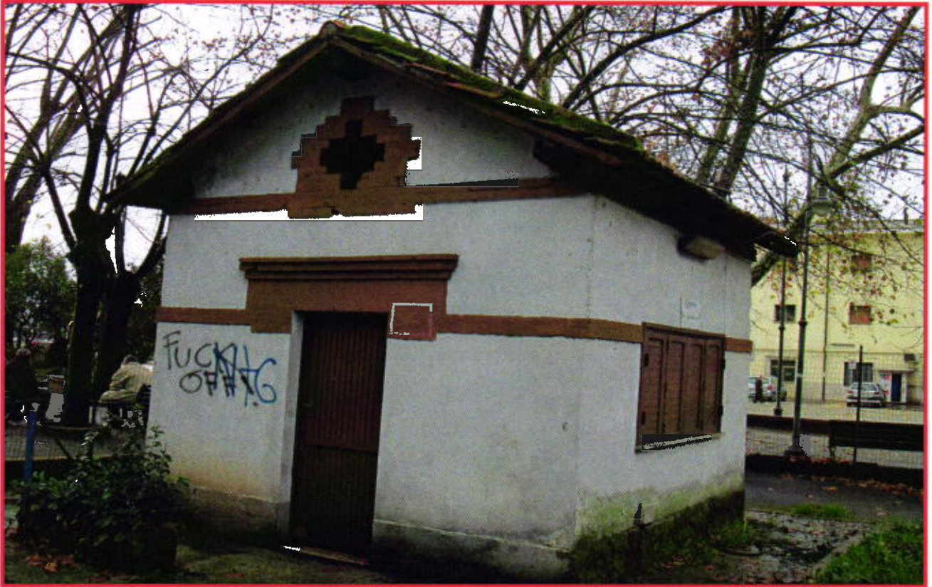
EDIFICIO "D" - vista frontale
