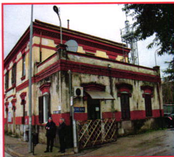
EDIFICIO "B" - vista laterale
